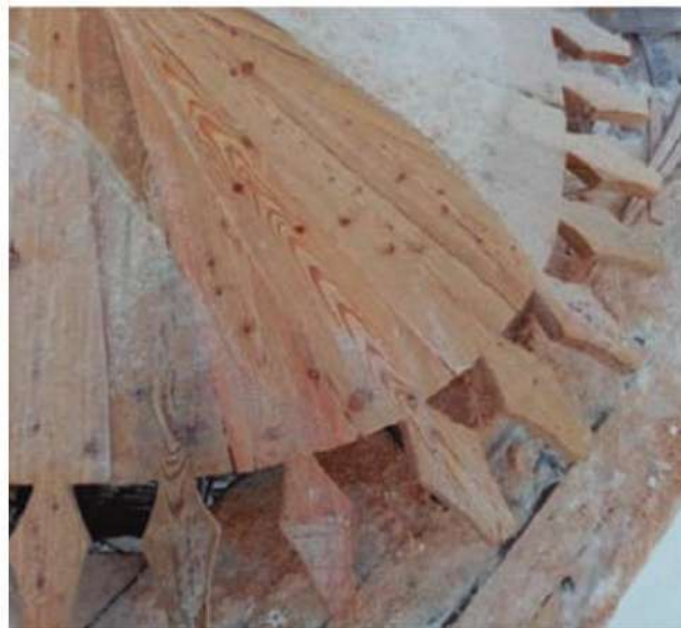
Рис. 5. Закругленный угол кровли юго-западной башни Братского острога во время реставрации в начале 2021 г.
